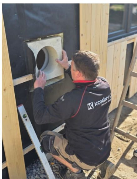
Instalace bezpečné průchodky
