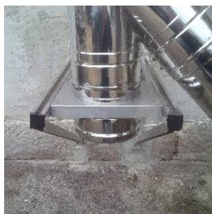
Základová deska průchozí
