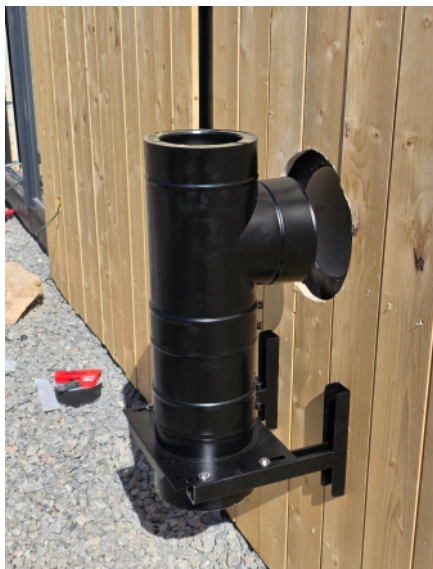
Základová deska s nádobou
