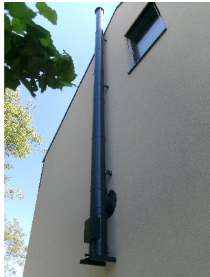
Osazení dvířkového čistícího dílu
