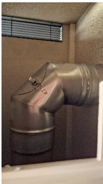
Detail zadního napojení na komín
