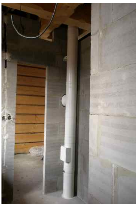
Založení na teleskopickou vzpěru
