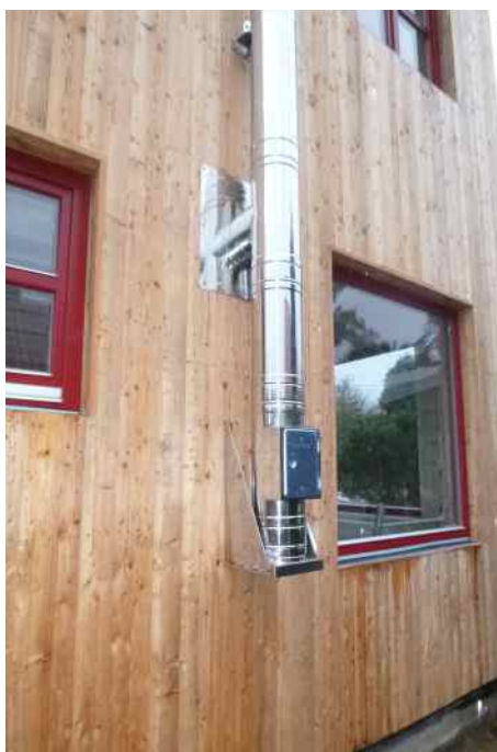
Založení pomocí konzole s dvířky
