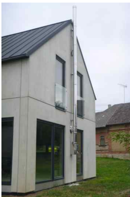
Založení pomocí konzole s dvířky
