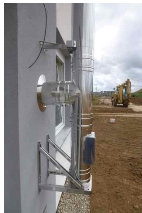
Založení pomocí stěnové vzpěry
