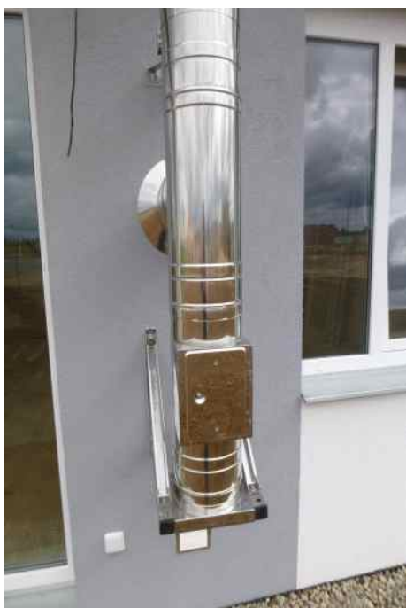
Založení pomocí konzole s dvířky
