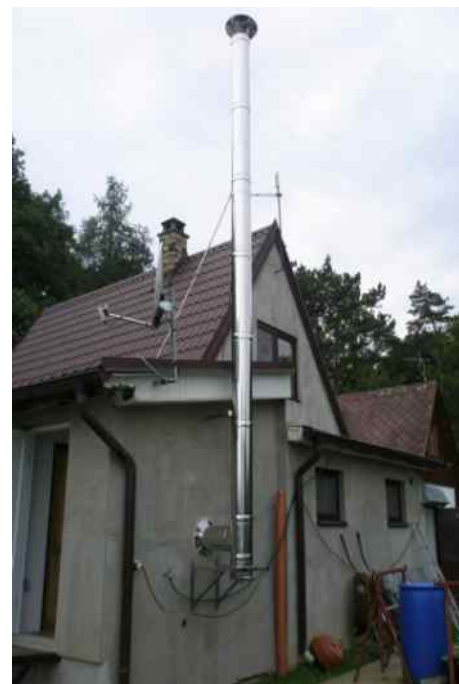
Upevnění vyšší nadstřešní části
