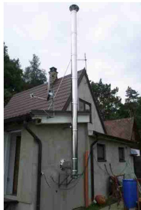
Upevnění vyšší nadstřešní části
