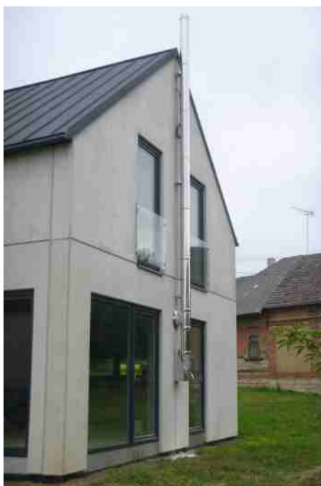
Založení pomocí konzole s dvířky
