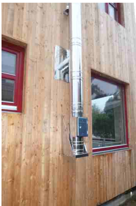
Založení pomocí konzole s dvířky
