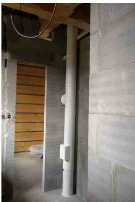
Založení na teleskopickou vzpěru
