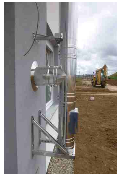
Založení pomocí stěnové vzpěry
