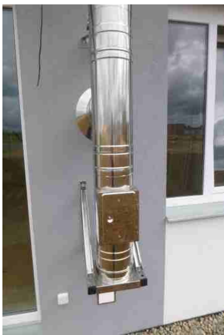
Založení pomocí konzole s dvířky
