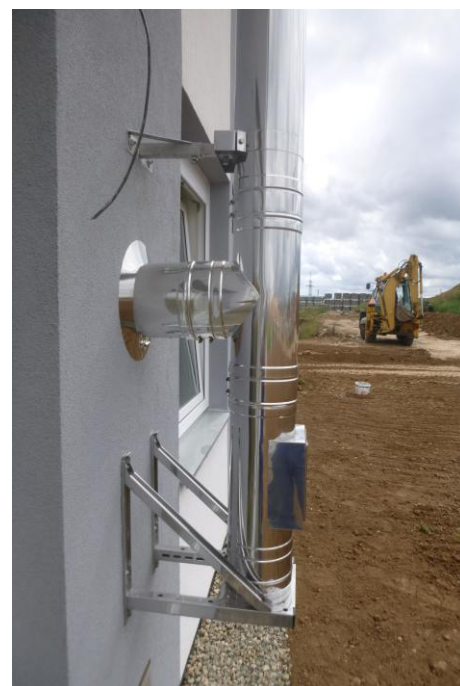
Založení pomocí konzole s dvířky
