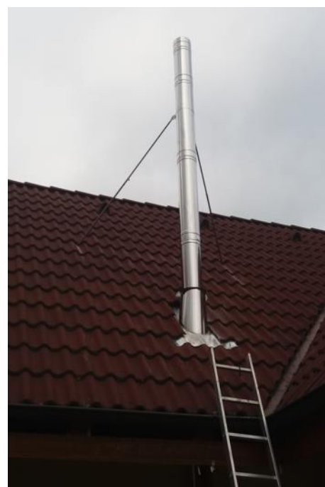
Upevnění vyšší nadstřešní části
