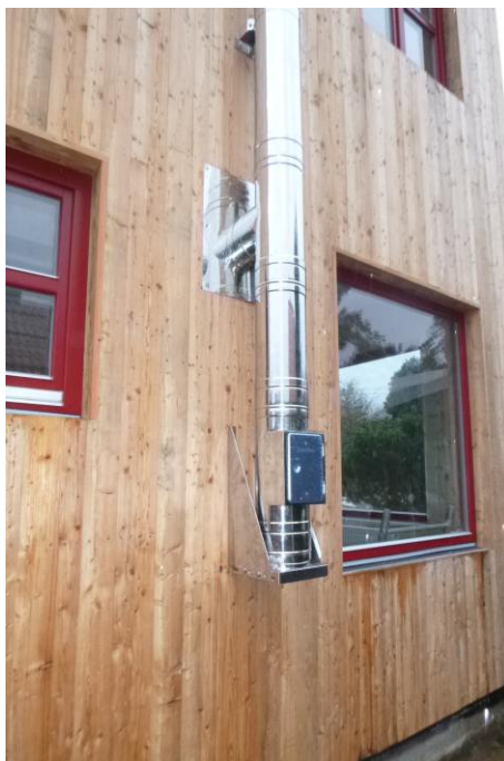
Založení pomocí konzole s dvířky
