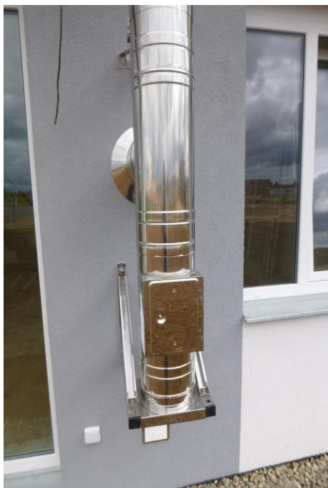
Založení pomocí konzole s dvířky
