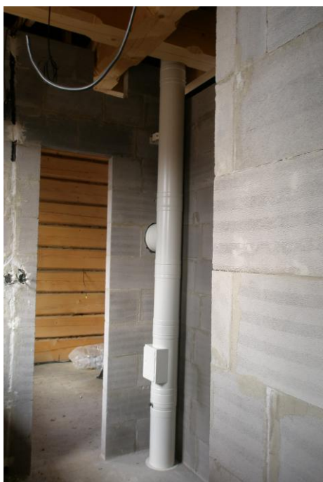
Založení na teleskopickou vzpěru
