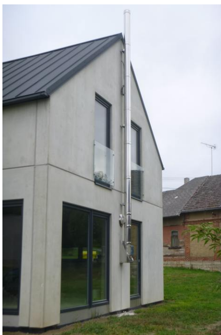
Založení pomocí konzole s dvířky
