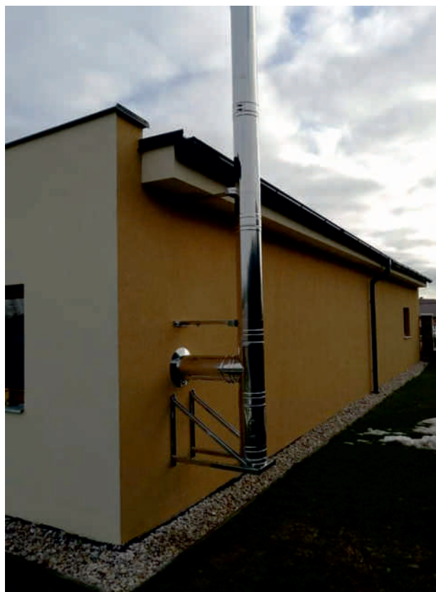
Upevnění pomocí delších držáků a konzole
