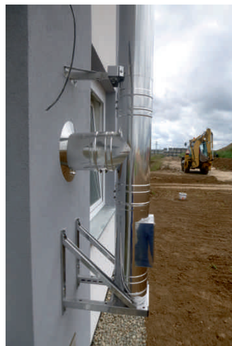
Založení pomocí stěnové vzpěry
