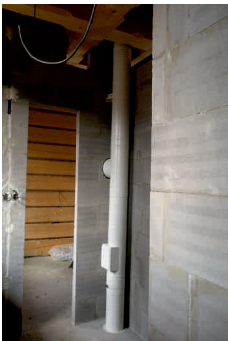
Založení na teleskopickou vzpěru
